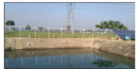
Figure 4. Réservoir d'eau communautaire utilisant des installations à énergie solaire
