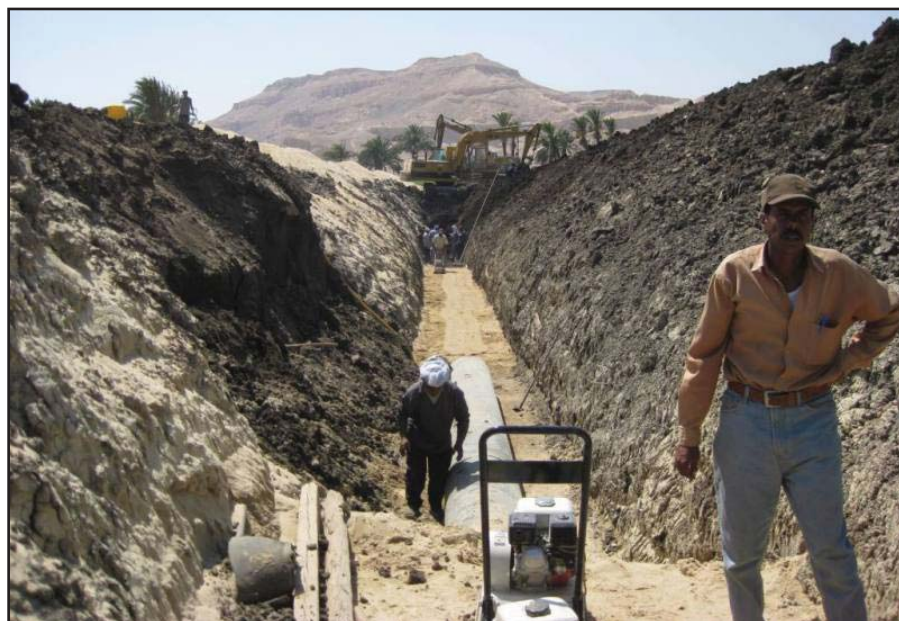
Installation d'un drain principal en Egypte supérieure
