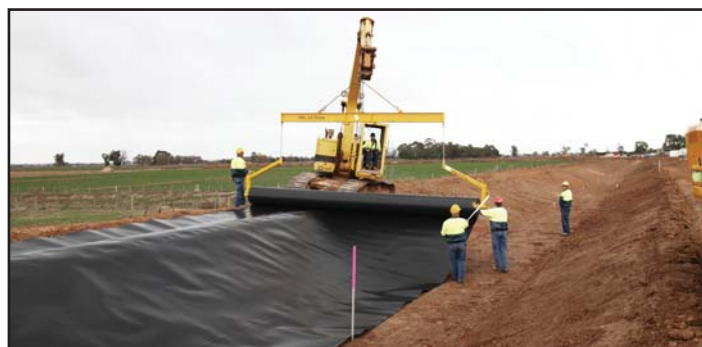
Revêtement du canal en plastique (HDPE)
